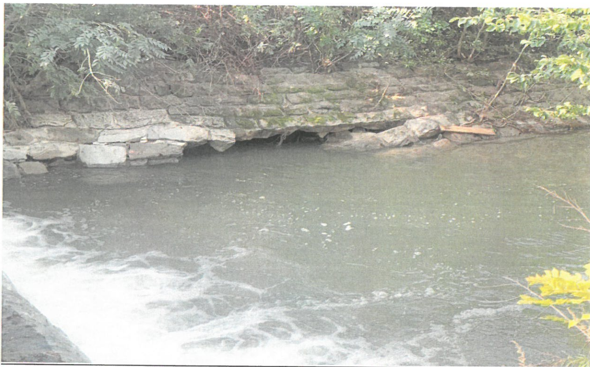
Poškozený stupeň a břehové opevnění
