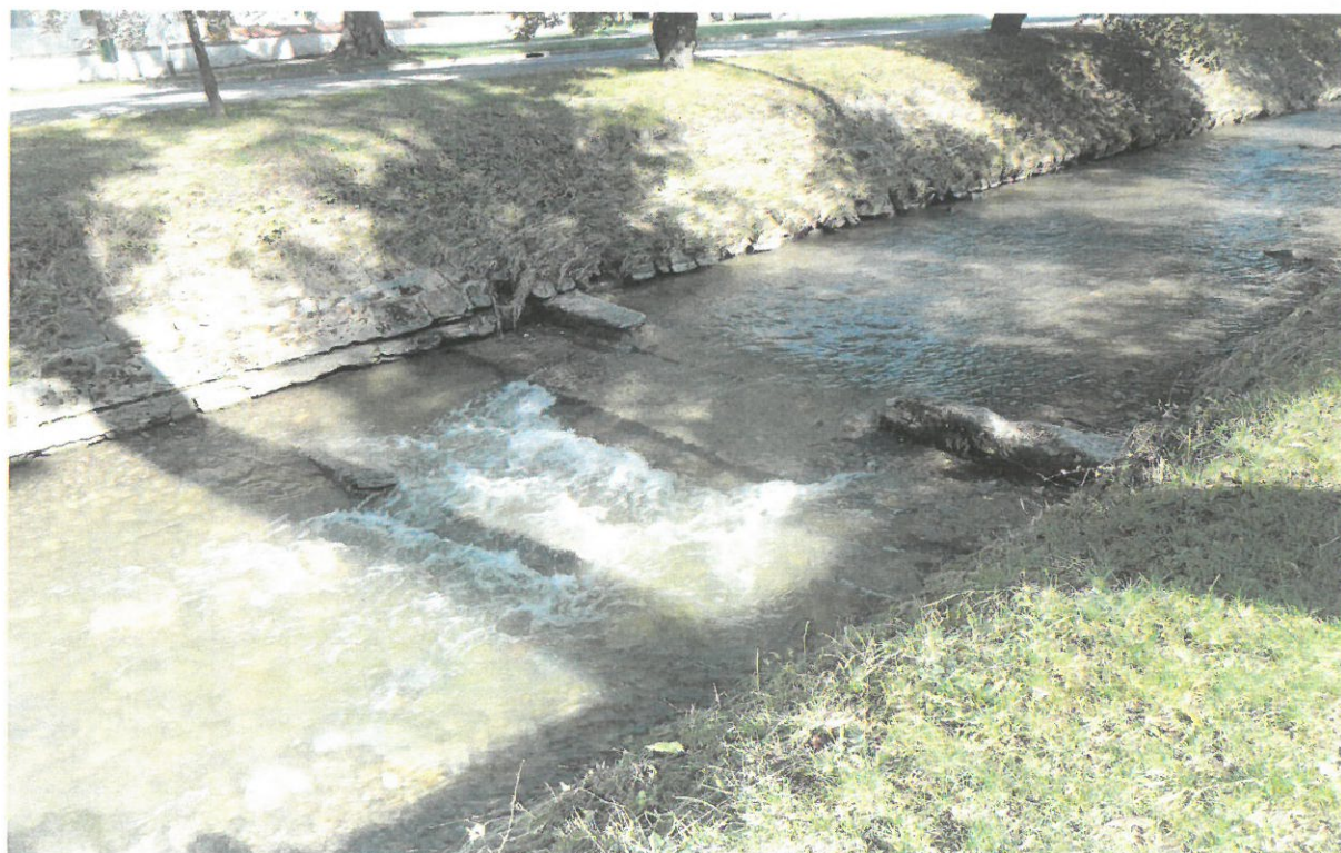
Poškozený stupeň a břehové opevnění
