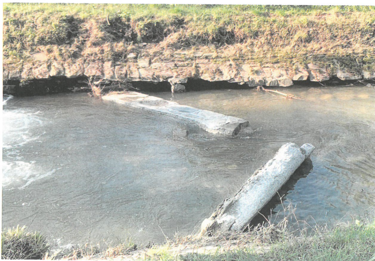
Poškozený stupeň a břehové opevnění
