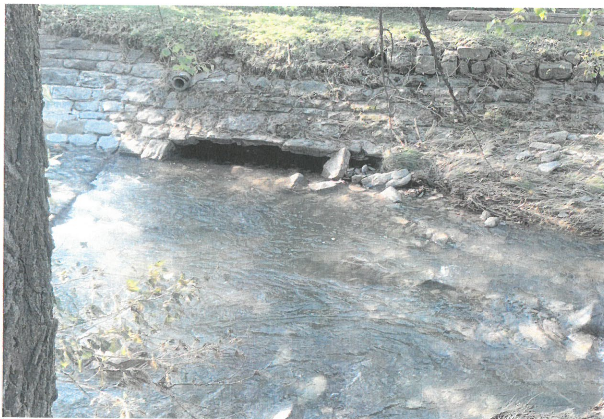
Poškozené břehové opevnění
