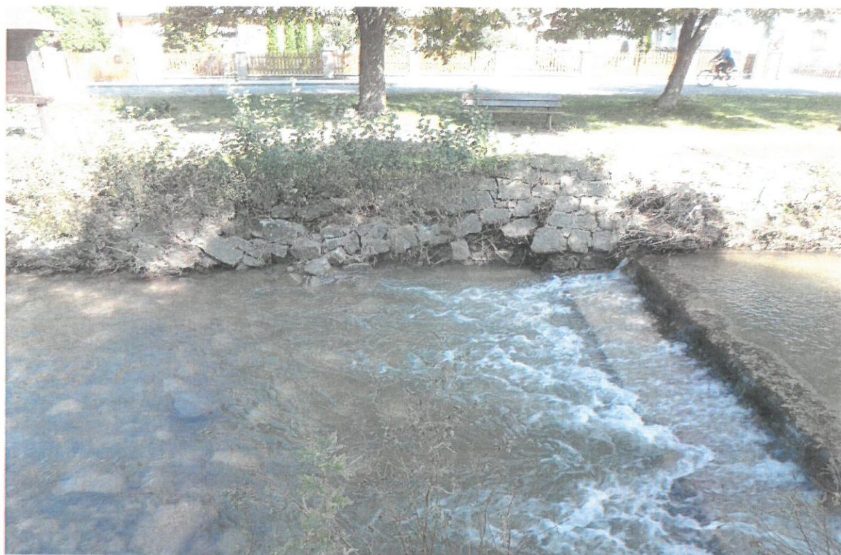
Poškozený stupeň a břehové opevnění
